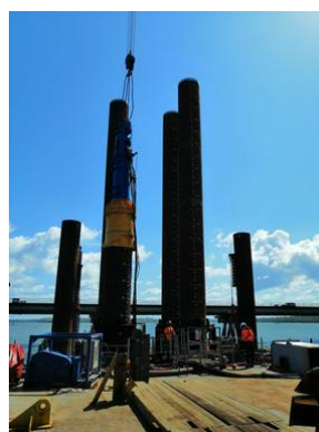
Battage de pieux au pont du Larivot © P. NAGL/GEPOG
